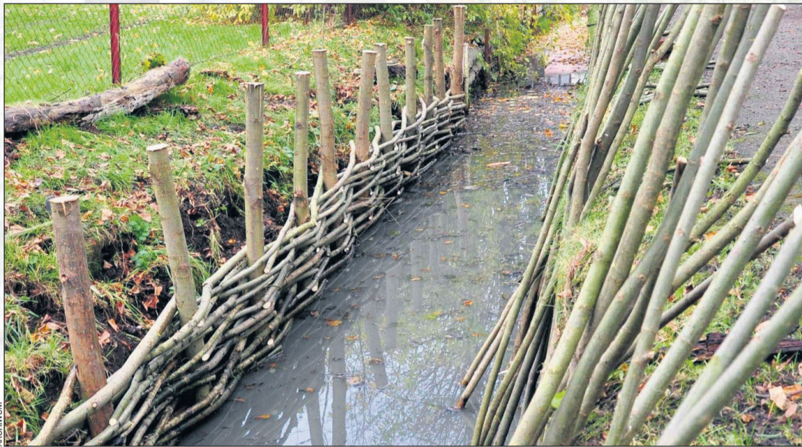
Faszyna służy do umacniania skarp
